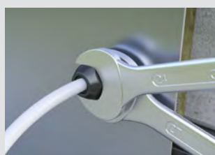
Kabel einziehen und die Druckmutter mit dem Schlüssel festziehen
